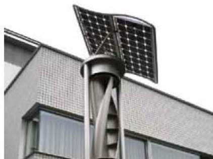
安装于 EU 生态住宅的混合型照明塔“风海鸥”
