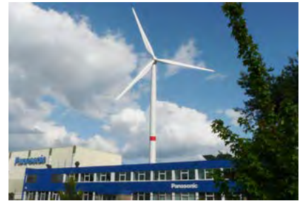
ベルギーの工場の風力発電システム
