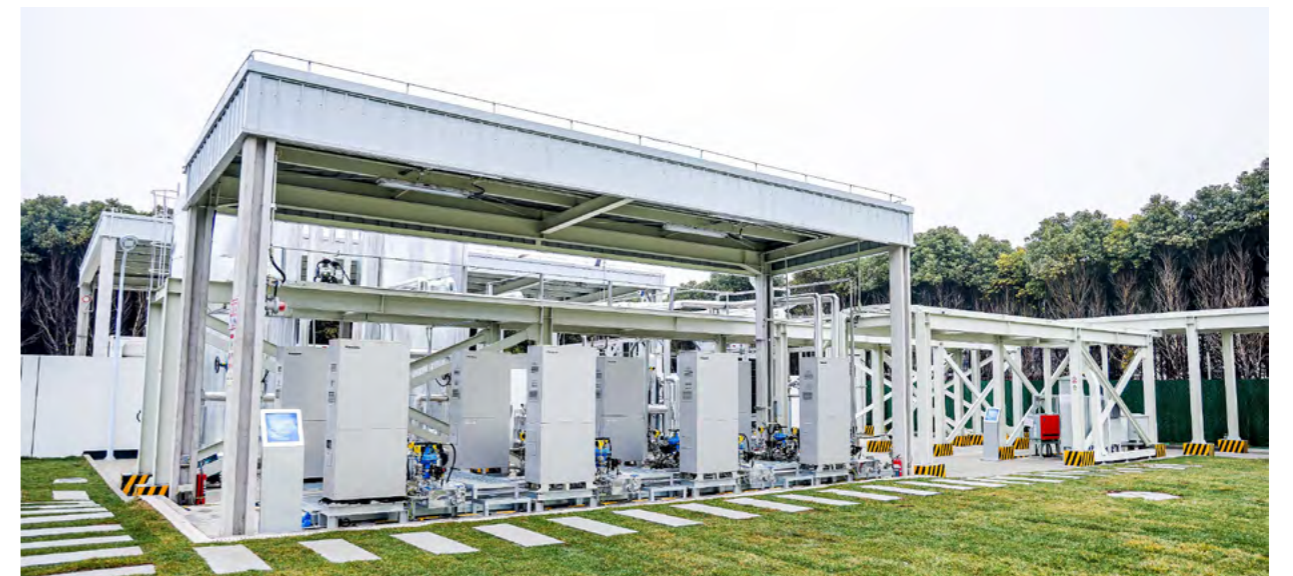
在江苏省无锡市的松下新能源（无锡）有限公司，打造首个氢能燃料电池综合能源利用项目“松下冷热电三联供氢能示范项目”。
