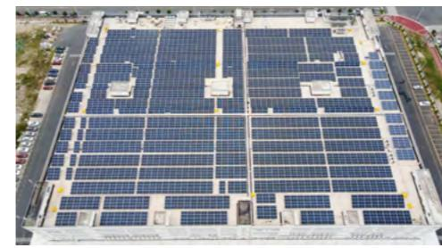
广东松下环境系统有限公司建立光伏发电系统，通过EMC(合同能源管理)模式进行导入，于2021年9月导入分厂、2022年7月导入总厂。2022年共计发电5,373mWh，减少CO<sub>2</sub>排放3,711吨，助力“零碳工厂”的实现。
