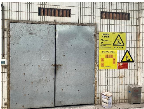
危险废物贮存场所
