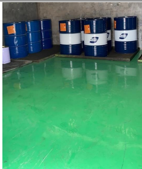
危险废物贮存场所
