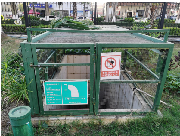
生活污水排放口
