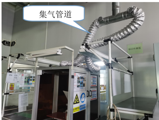
移印废气收集装置
