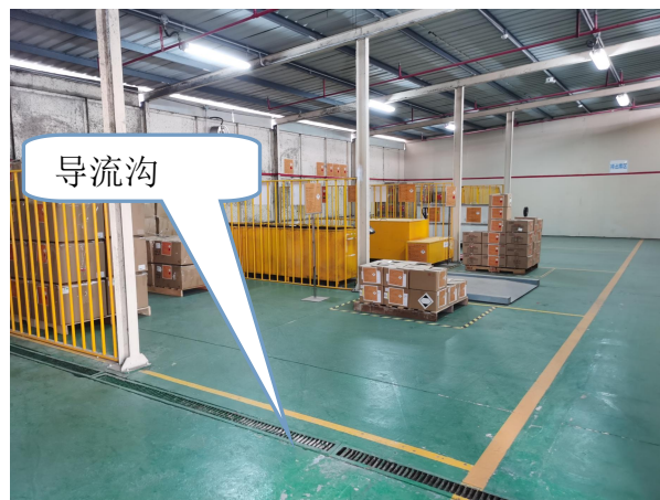
危险废物仓库内部（分类标识、托盘、地板防渗、导流沟）
