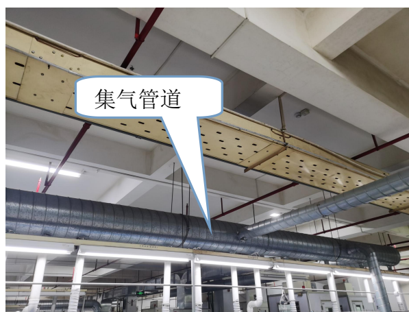
焊接废气收集装置
