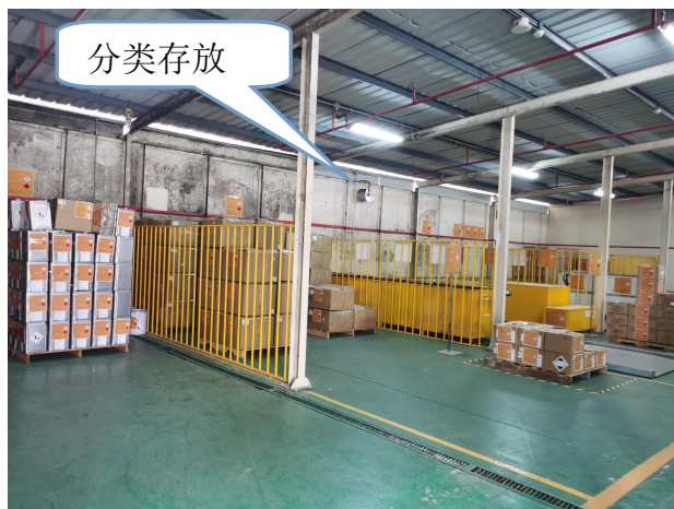
危险废物仓库内部（分类标识、托盘、地板防渗、导流沟）
