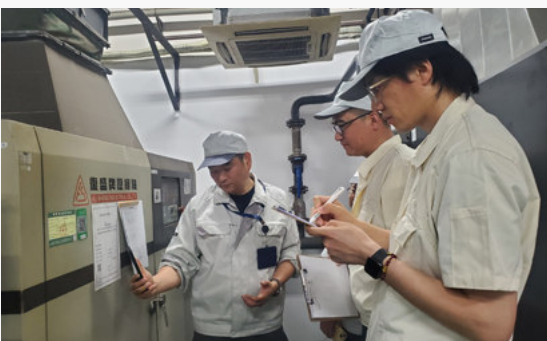
节能诊断现场
