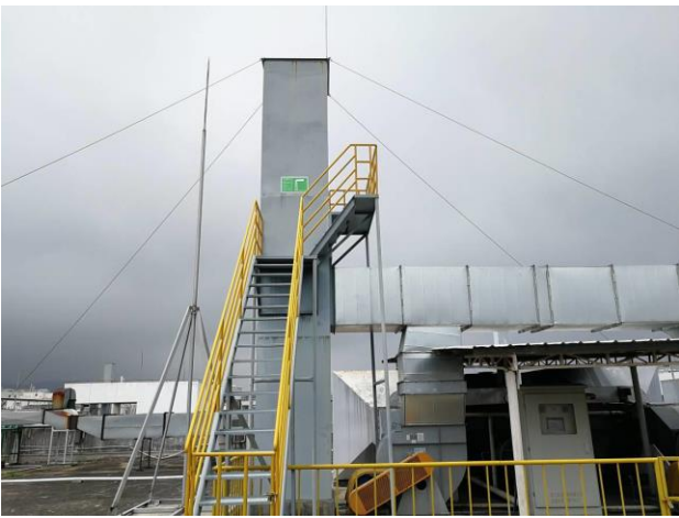
有机废气收集装置、活性炭吸附装置、排气筒
