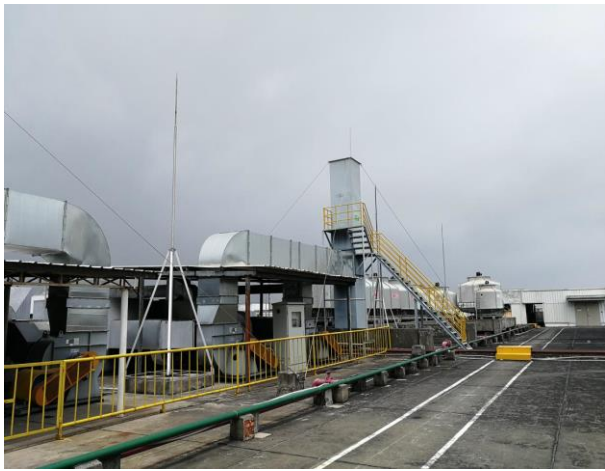
有机废气收集装置、活性炭吸附装置、排气筒
