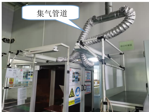
移印废气收集装置
