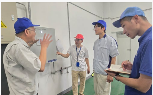
节能诊断现场
